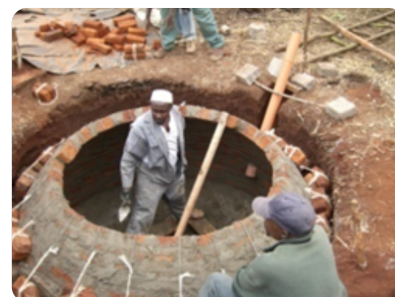
Bau von Biogasanlagen für Haushalte in Kenia
